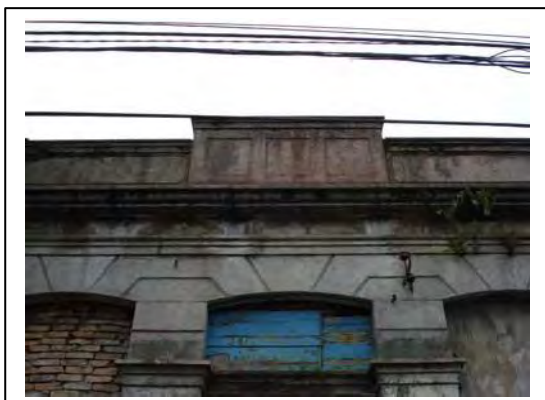
Detalhe da fachada
