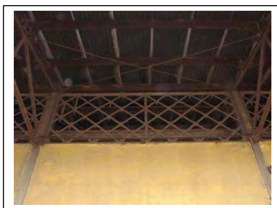
Detalhe de grade metálica de fechamento da cobertura
