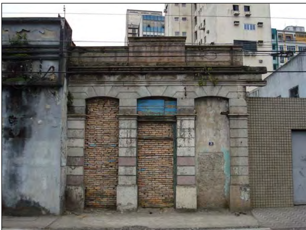
Foto 9 – Edificação térrea localizada na Rua Xavier da Silveira.
