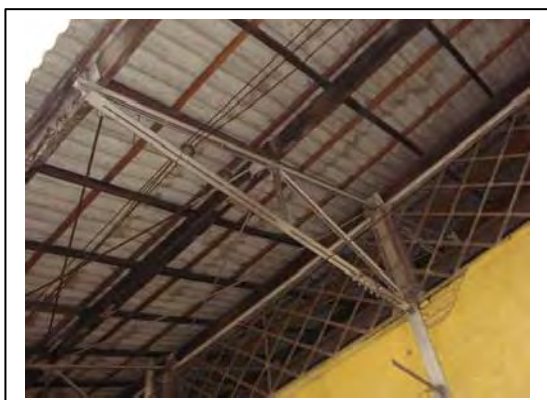
Detalhe da tesoura metálica
