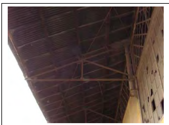
Detalhe da tesoura metálica
