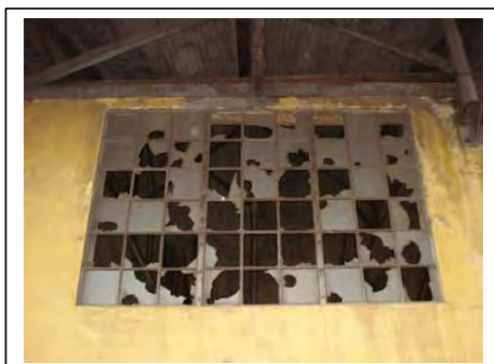
Detalhe da vidraça
