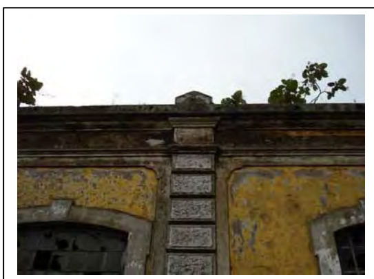
Detalhe de cunhal e cimalha
