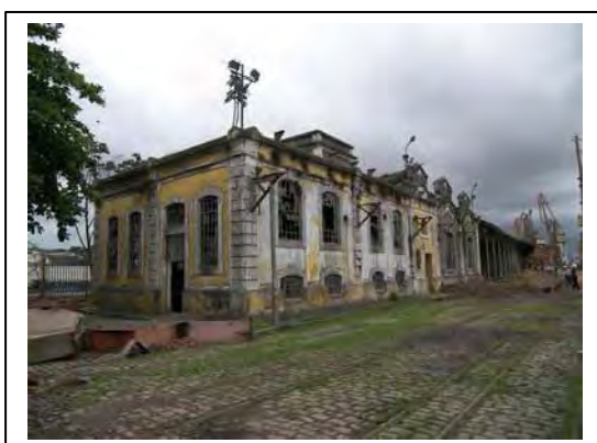
Vista da parte interna
