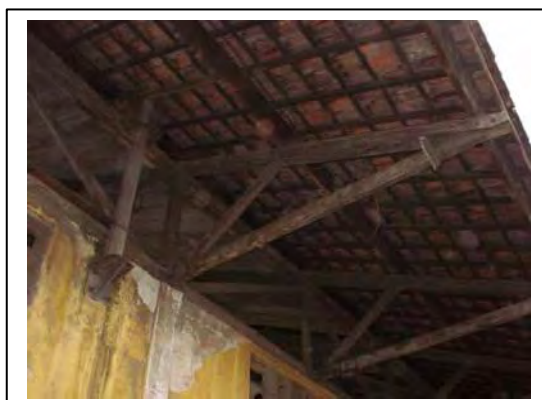
Detalhe da tesoura de madeira
