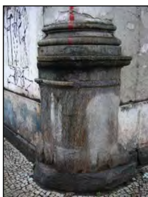
Detalhe do Soco em cantaria.
