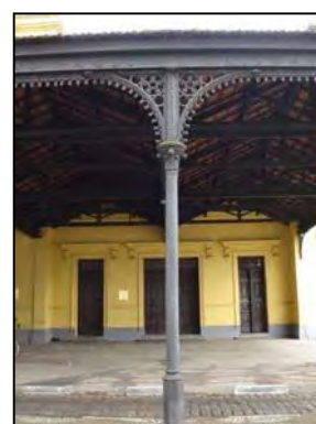
Detalhe da coluna decorada de ferro fundido do alpendre frontal
