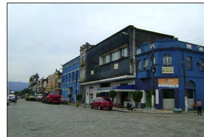
Rua São Bento (Notar as edificações de períodos distintos).
