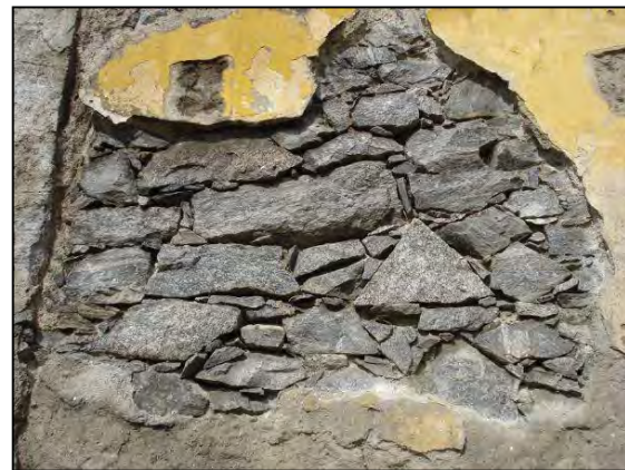
Detalhe da Parede em pedra e cal
