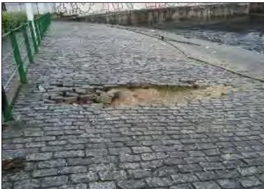
*Foto 2 – Desagregação dos blocos e erosão das rampas – Praça Iguatemi Martins*
