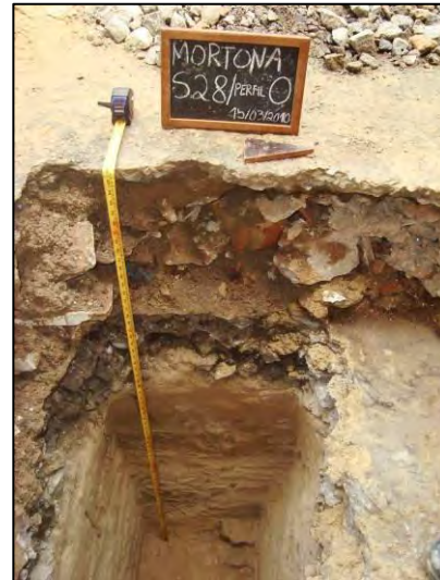
Perfil Sul, observando-se a camada inicial de concreto [01], o aterro recente [02] sob essa e sobre o piso original do Galpão 1 [03A], o preparo de brita grossa [04] para colocação do piso e a areia natural de praia [05].
