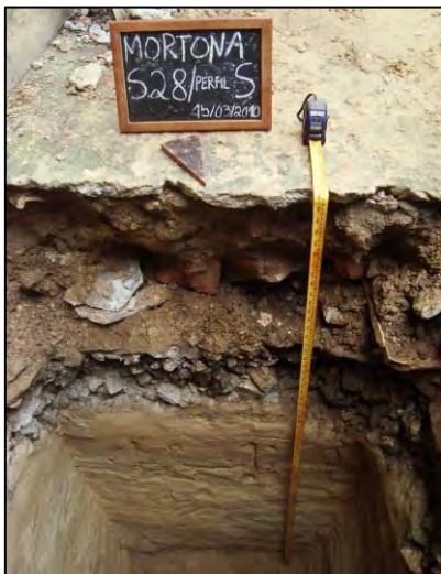
Metade Sul do Perfil Este observando-se a parede [06] do Galpão sob o piso original do mesmo [03A], mostrando ser posterior a esse, o preparo de brita grossa [04] para colocação do piso e a areia natural de praia [05].
