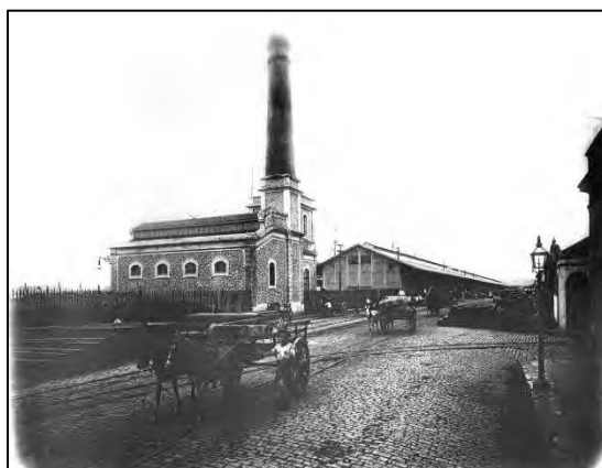
Figura 5 - Casa de Máquinas Compressoras possivelmente situada entre os armazéns 8 e 9. 1904 10
