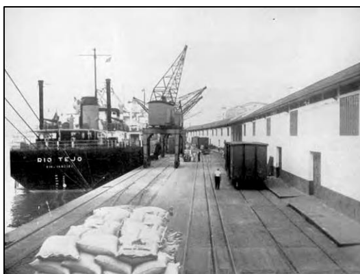
Figura 17 – Armazéns em alvenaria com a mesma tipologia dos armazéns 1, 2, 3 e 417
