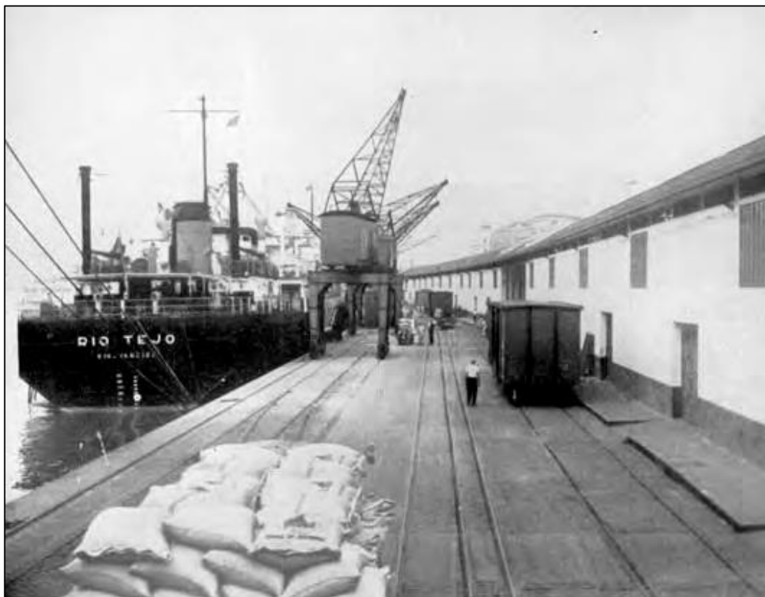
Figura 13 - Trecho da faixa do cais destinado aos navios de cabotagem, servido por guindastes elétricos de 1,5 toneladas. Estes armazéns tem a mesma tipologia dos armazéns 1, 2, 3 e 4. 15
