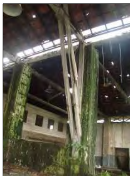
Detalhe da estrutura do telhado e coluna de pedras.
