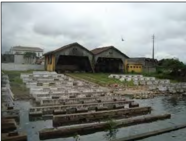
Edifício de Manutenção e Atracadouros Laterais.
