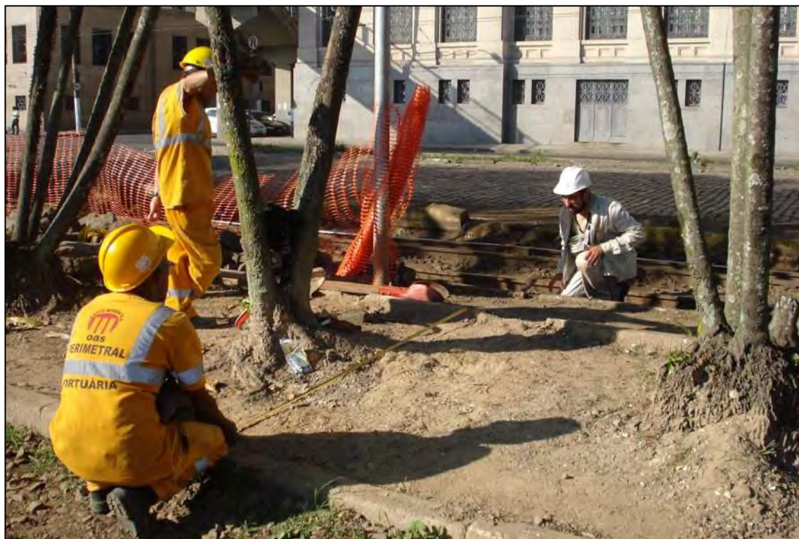
Vista geral do local de abertura do PT.
