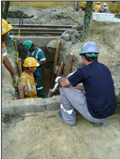
Trabalhos de escoramento da sondagem.
