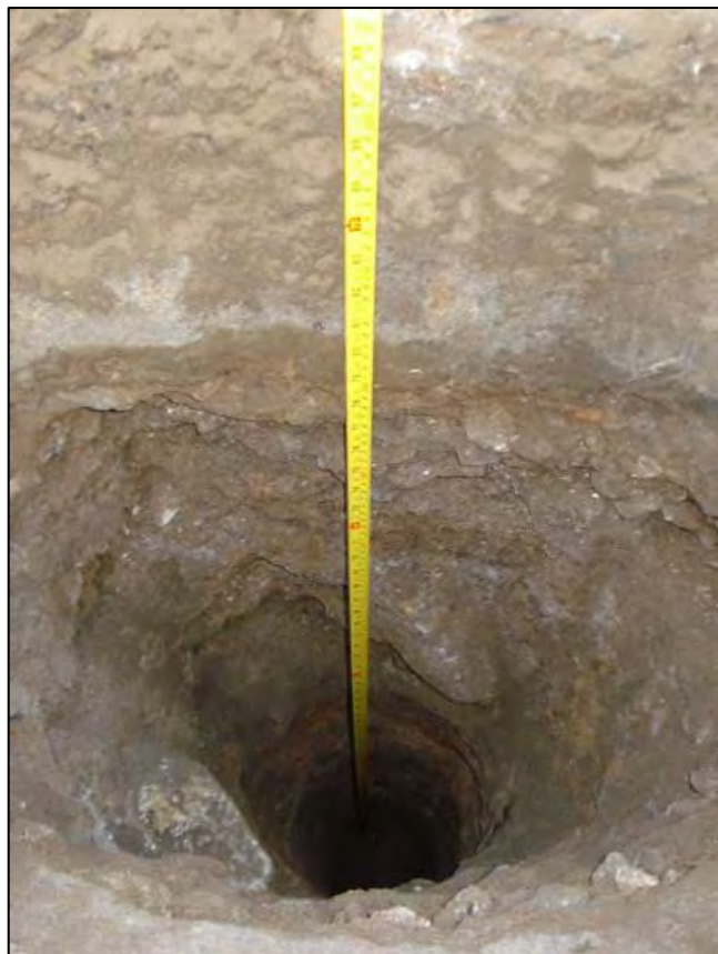
Aprofundamento do PT e medição de profundidade.
