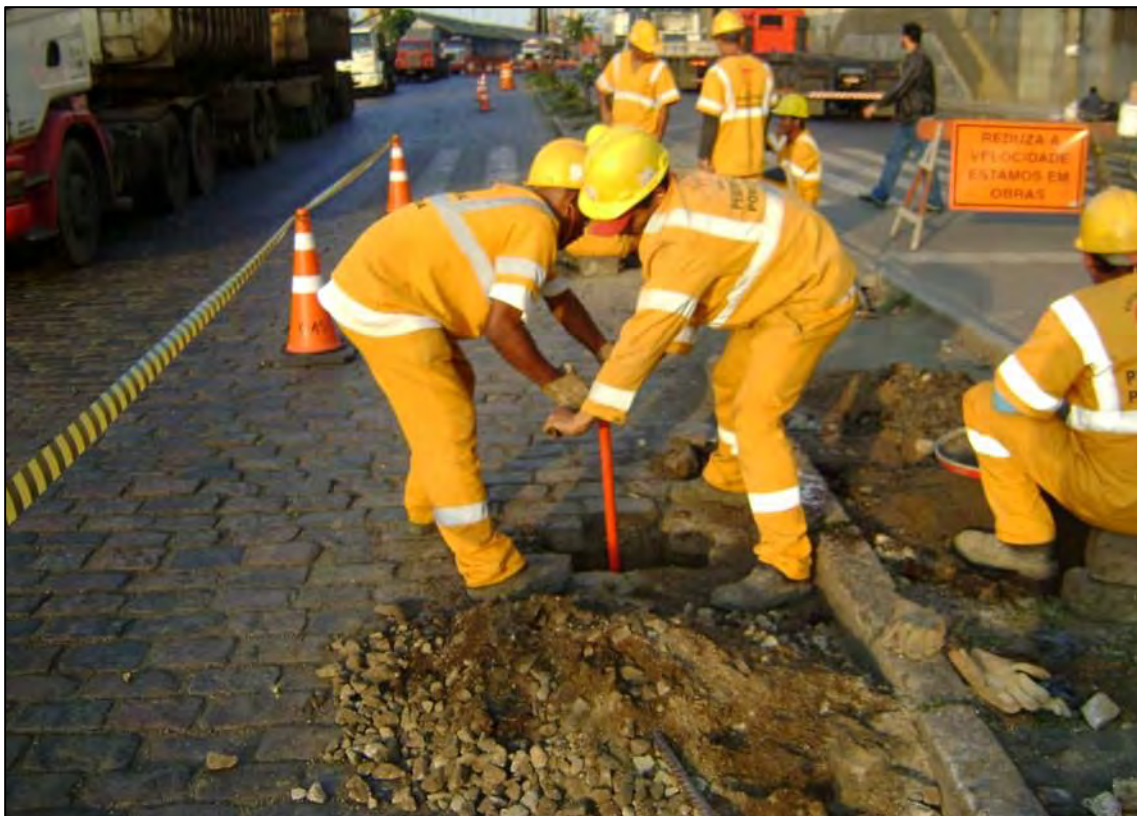
Vista geral do local de abertura do PT.
