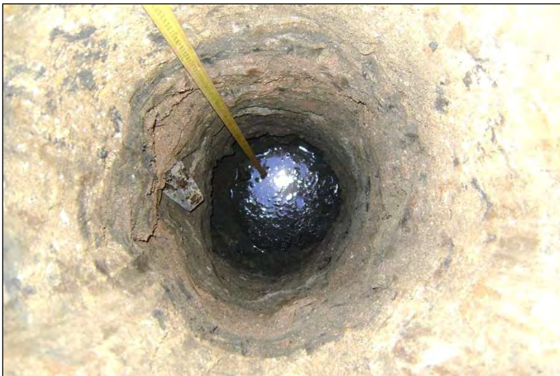
Aprofundamento do PT e medição de profundidade.
