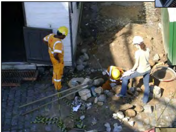
Aprofundamento dos trabalhos, sempre mais restritos devido aos blocos de aterro e restos de edificações.
