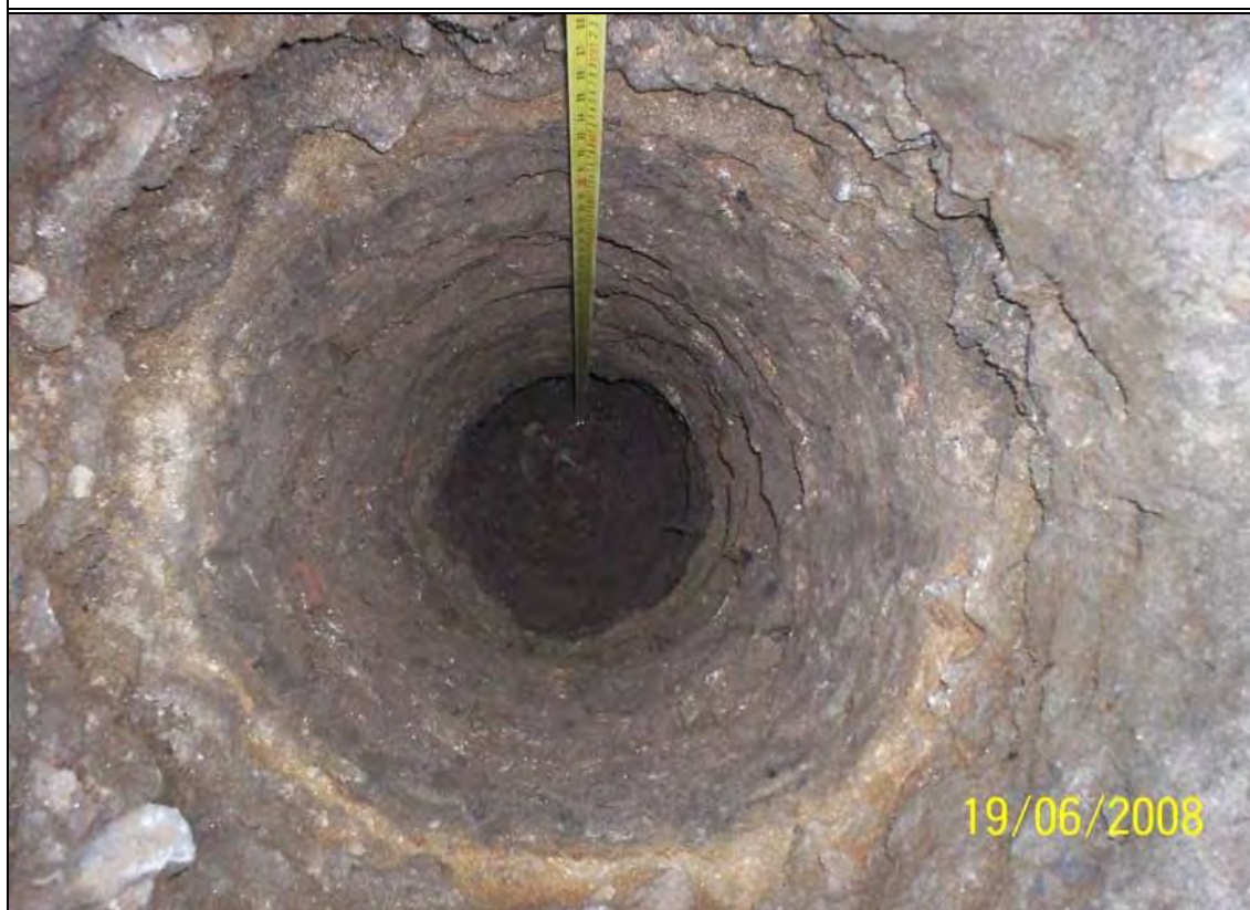
Aprofundamento do PT e medição de profundidade.
