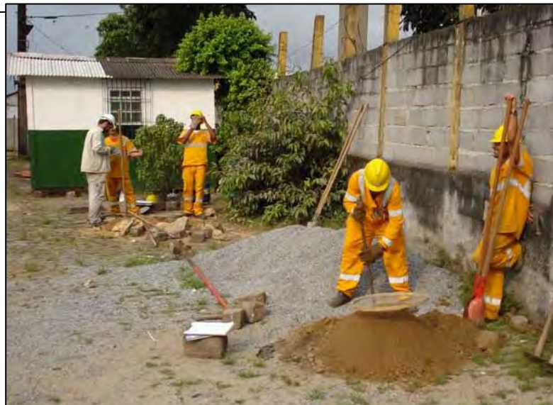
Vista geral do local de abertura do PT.
