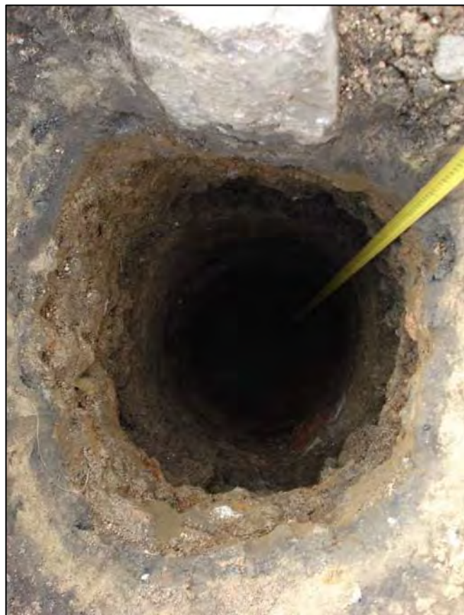
Aprofundamento do PT e medição de profundidade.
