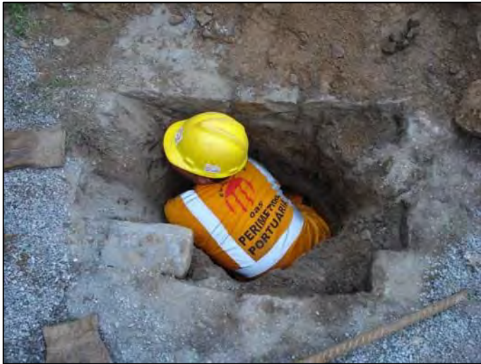
Aprofundamento do PT com retirada de bloco.
