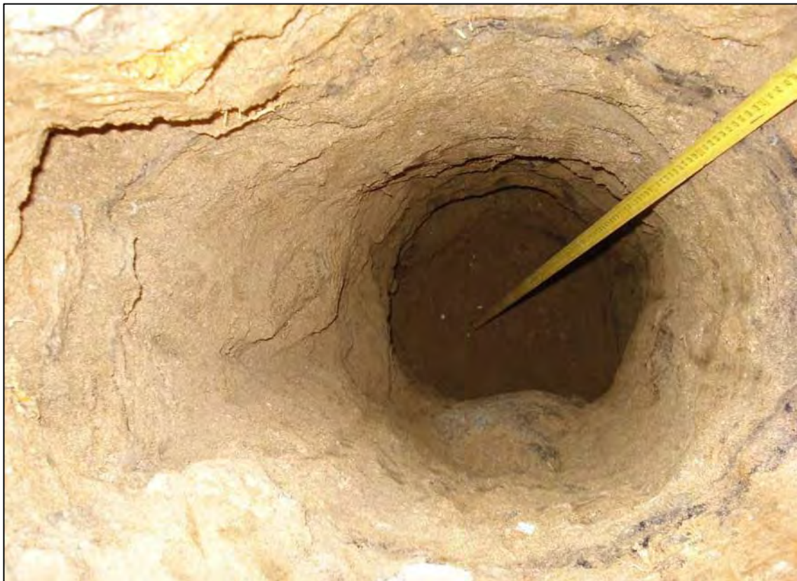
Aprofundamento do PT e medição de profundidade.
