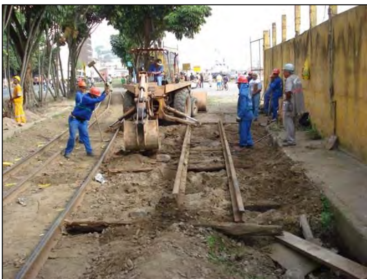
Vista geral do local de abertura do PT.
