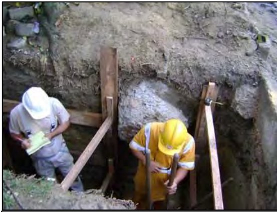
Recobrimento do piso com lona para fechamento da sondagem.
