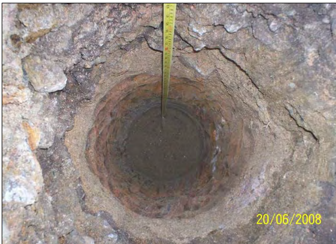
Aprofundamento do PT e medição de profundidade.
